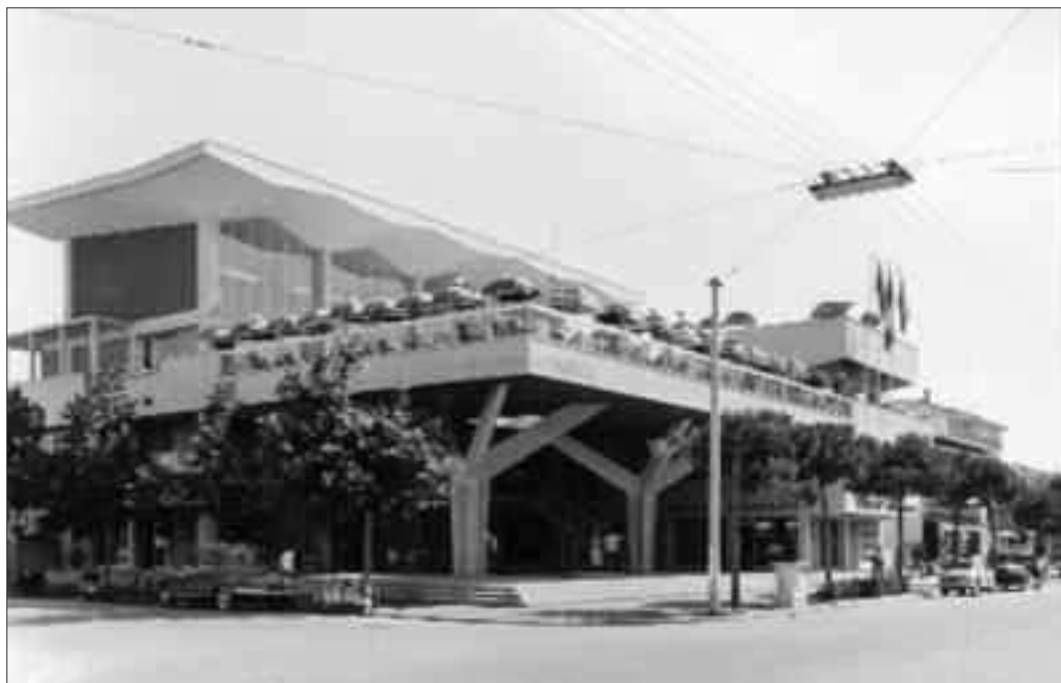
9. Palazzo del Turismo (progetto di Saul Bravetti, 1957), Cesenatico. Foto dei primi anni Sessanta.
