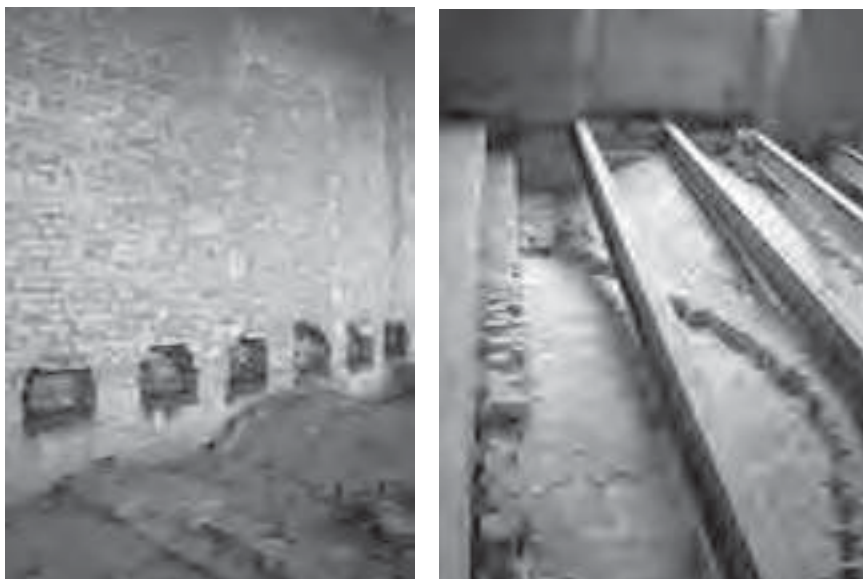
Figg. 21-22 Ivano Giovannini, Ristrutturazioni , 2004. Lavori di ristrutturazione al primo piano della biblioteca (BCM, Fondo Ivano Giovannini, FGV lavori copia 4 e 7)
